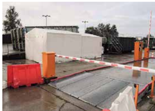
De asbestcontainer in Koksijde: een voorbeeld. (foto KW)
