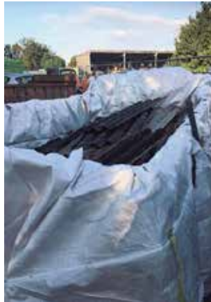
De asbestcontainer in Lichtervelde. (foto KW)
