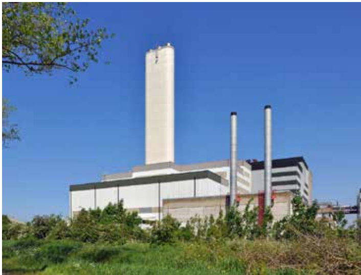
De afvalverbrandingsinstallatie van IVBO in Brugge, waarvan de restwarmte nu al een warmtenet voedt. Bedoeling is dit net nog uit te breiden.
