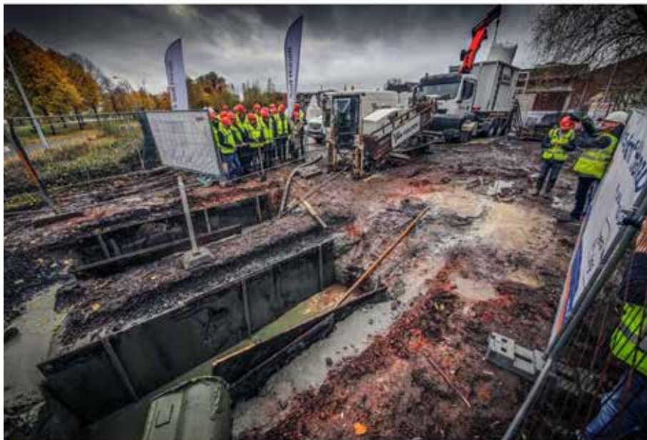
© Henk Deleu - Archiefbeeld: de live onderboring van de Leie, het sluitstuk van de aanleg van het warmtenet in Kuurne. Foto Henk Deleu
