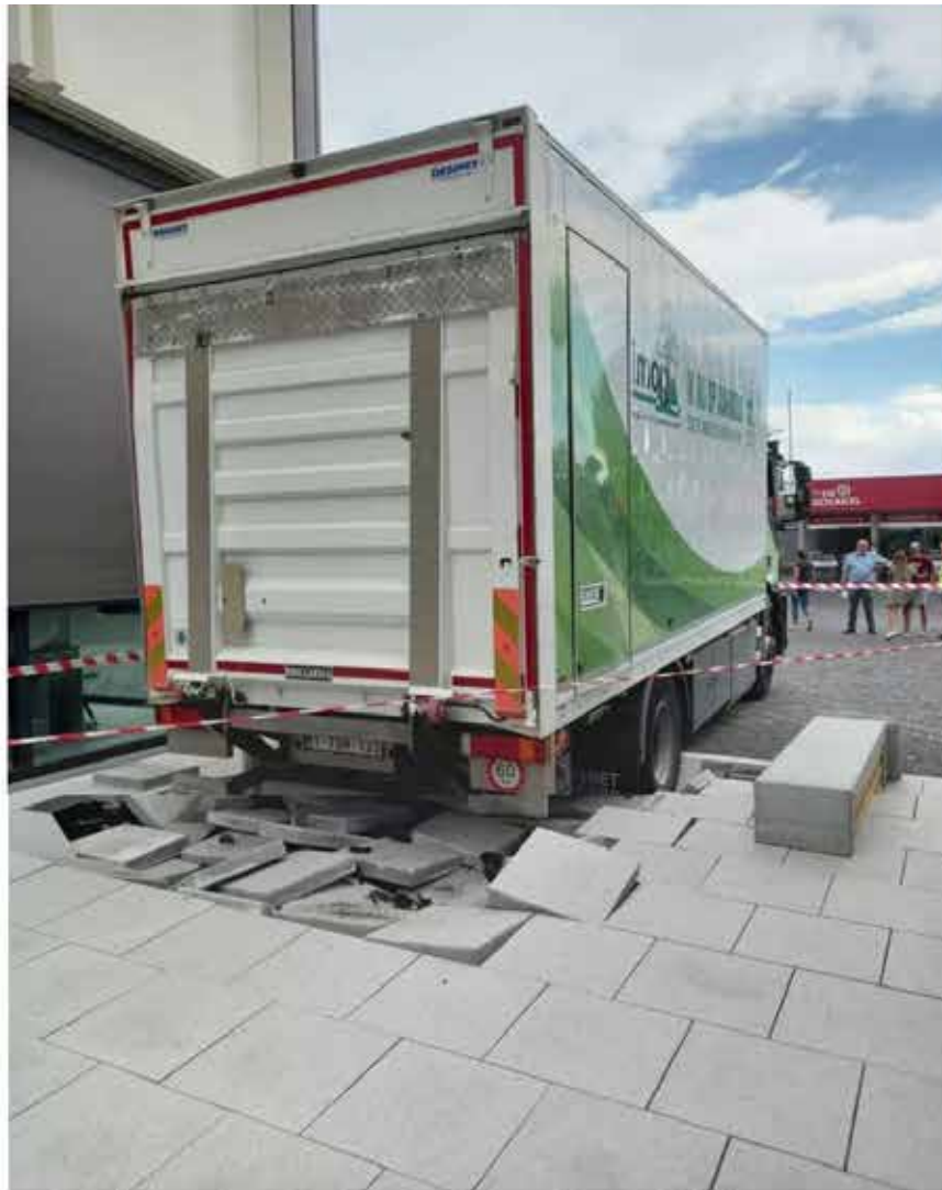
De vrachtwagen van Imog zakte door de nieuwe tegels aan het vernieuwde Pand © rv
