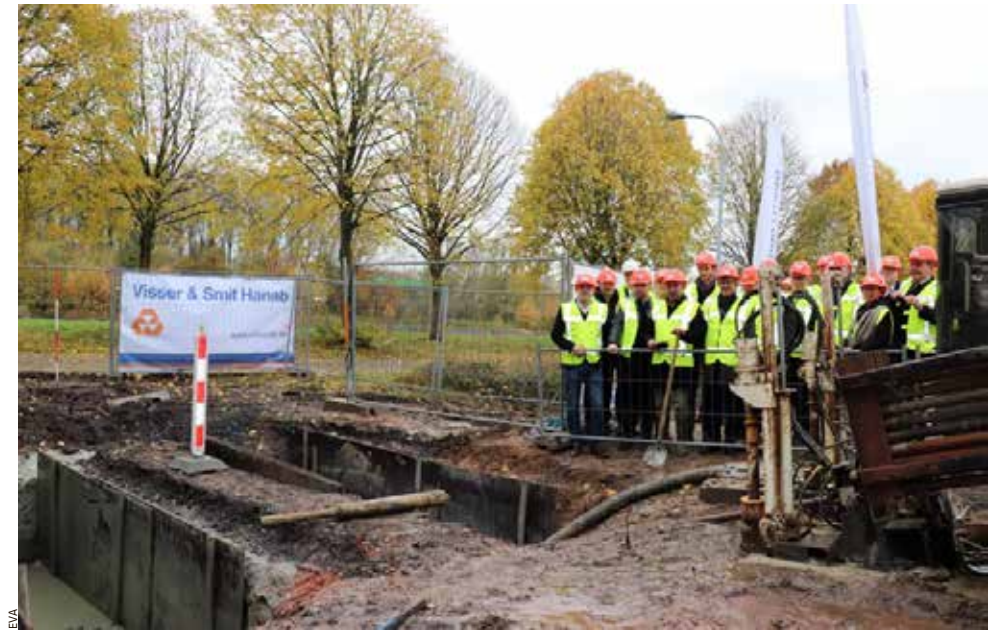
■ In Kuurne wordt een buis van 6 ton onder het water getrokken om boven te komen in Harelbeke.
