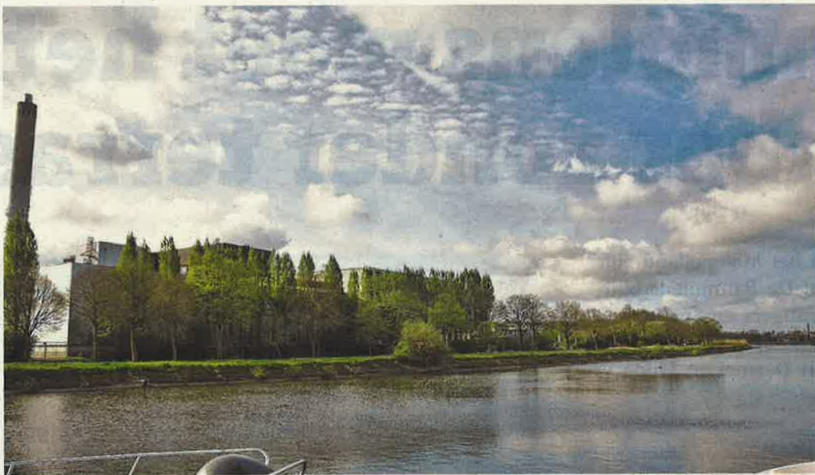
De Leie moet ook ter hoogte van Imog verbreed worden. Die werken zullen pas na de Leiewerken plaatsvinden. (Foto LOO)
