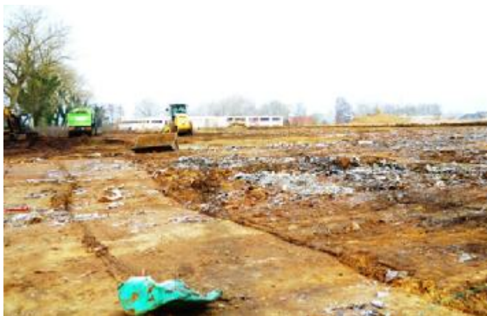
Bij het bouwrijp maken van de grond wordt afval blootgelegd. © pdv
