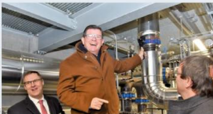
Minister Bart Tommelein draaide gisteren de pomp van het warmtenet open.
