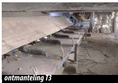
demonteren bestaand rookgaskanaal
