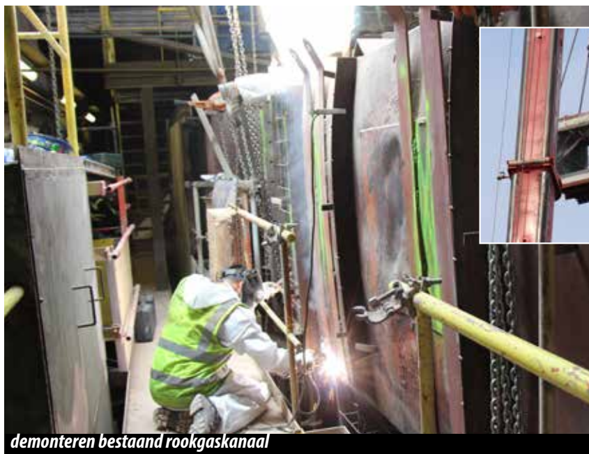
hijswerken vervanging rookgaskanaal
